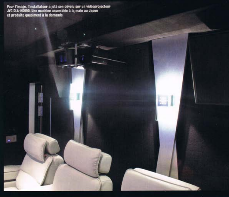
Pour le son, l'installateur a opté pour une solution tout-en-un avec le mur d'enceintes Divatech Biosonic Mach III. Un mur acoustique intégrant 12 HP de 27 cm pour le grave, 6 HP de 27 cm pour le médium et trois pavillons pour les trois voies frontales.
