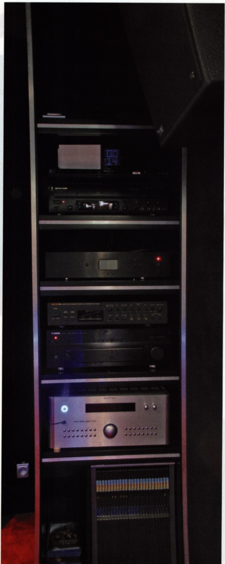
Jacques ne voulait pas de rack. L'installateur a donc créé un meuble sur mesures avec un double fond pour cacher les câbles.
